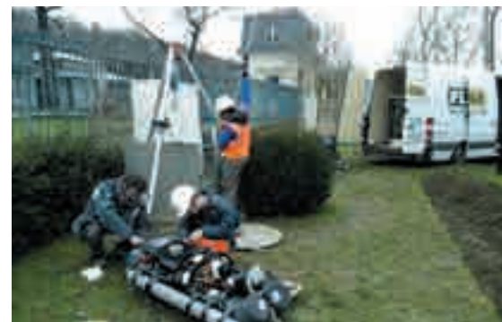
Préparation de la mise à l'eau d'un engin expérimental de visite des émissaires.
