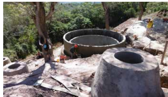
Construction de la station d'épuration de Jucuaran au Salvador.
