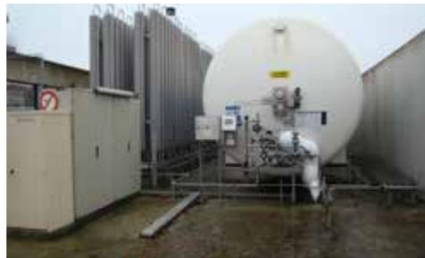
Le SIAAP entretient quatre dispositifs qui permettent d'injecter de l'oxygène dans la Seine afin de créer des îlots de survie pour les poissons en cas de fortes pluies. Ses équipes d'astreinte les ont actionnés à plusieurs reprises en 2020, entre mai et septembre.
