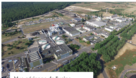
Vue aérienne de l'usine Seine aval
