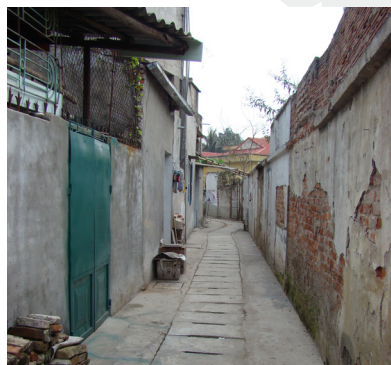
Chantier sur le réseau d'assainissement.
