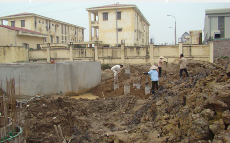
Chantier de la station de l'hôpital.
