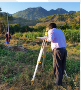
Terrain de construction du filtre.
