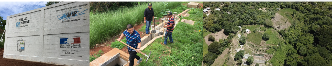
Construction de la station de traitement des eaux usées.
