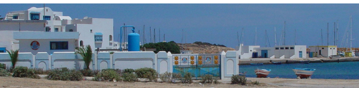
Station de traitement des eaux usées de Tunis.
