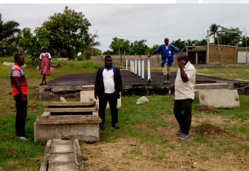
Collecteur d'arrivée des eaux sur la station.
