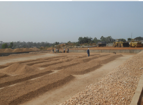
Construction des filtres.
