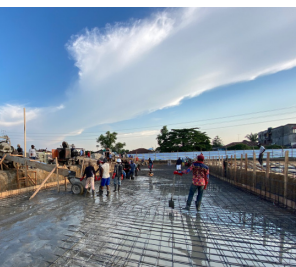
Construction du filtre planté
