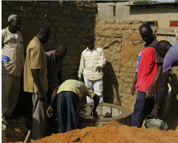
Construction d'un puitsard.
