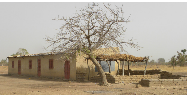
Latrines d'une école à Kayes.
