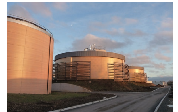
Digesteurs – Seine Grésillons
