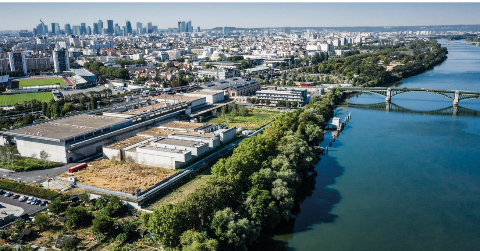
Usine Seine centre intégrée au paysage urbain
