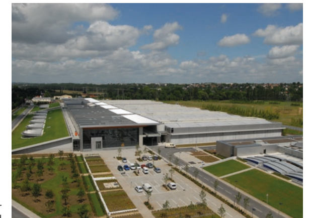
Traitement biologique par biofiltration - Seine aval
