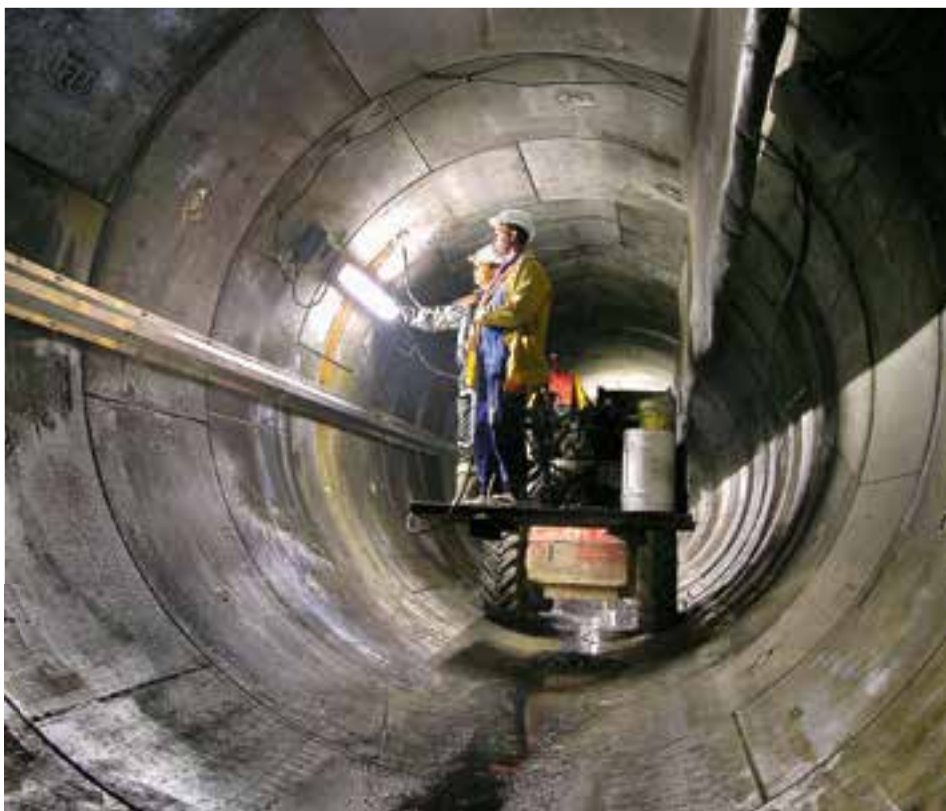
INTERVENTION D'UNE ÉQUIPE DE MAINTENANCE AU SEIN DU RÉSEAU DU SIAAP.
