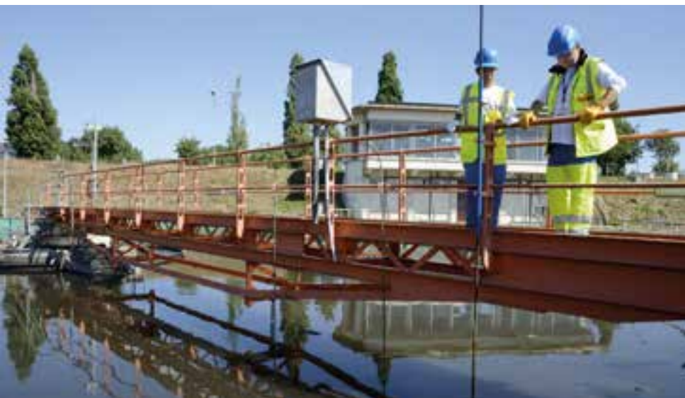
DES AGENTS EN INTERVENTION SUR UN BASSIN DE DÉCANTATION, L'UNE DES ÉTAPES DU PRÉTRAITEMENT.
