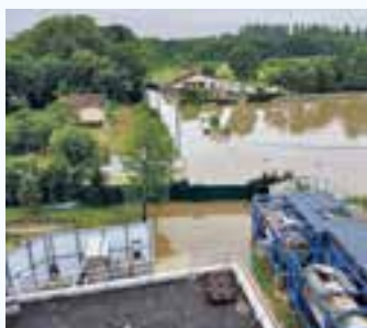
STATION DE RELEVAGE DE CROSNES, INNONDÉE LE 3 JUIN 2016 APRÈS LE DÉBOURDEMENT DE L'YERRES.
