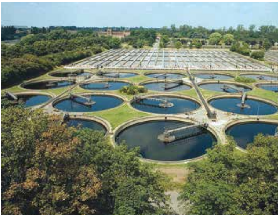
LA STATION THAMES WATER, À LONDRES, VISITÉE PAR LES AGENTS DU SIAAP EN 2016.
