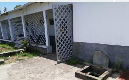
Installation du bloc sanitaire.
