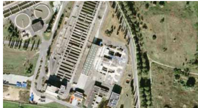
Vue aérienne du prétraitement en 2012
