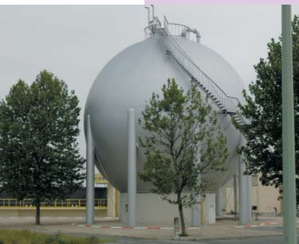
Figure 45 : Sphère de stockage du biogaz (Seine aval)
