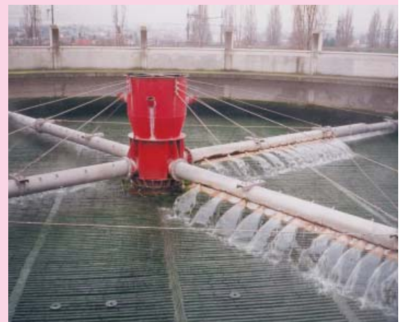
b. Système d'arrosage d'un lit bactérien (Marne aval, plus en activité)
