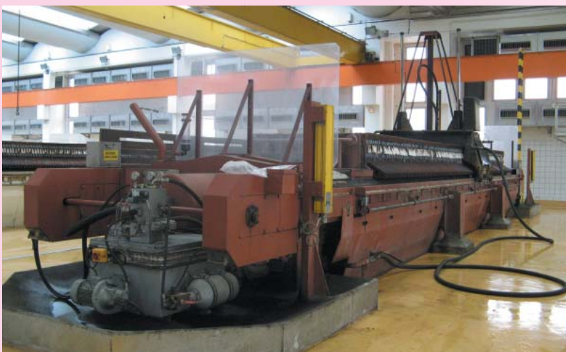
b. Filtre-presses (Seine aval)
