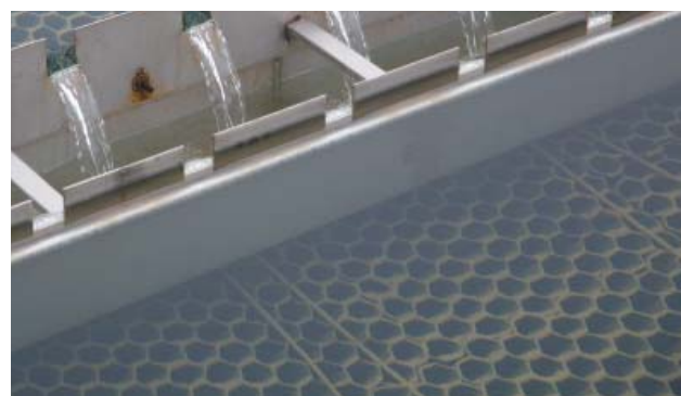
b. Décanteur lamellaire
