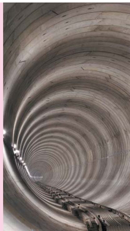
Figure 41 : Vue intérieure de TIMA (en construction)
