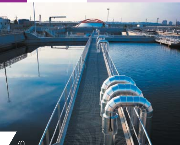
Figure 47 : Bassin de déphosphatation biologique (Seine amont)
