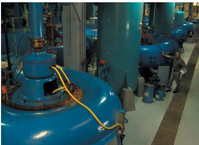
Figure 40 : Pompes d'un poste de relevage du SIAAP (usine de prétraitement de Clichy)
