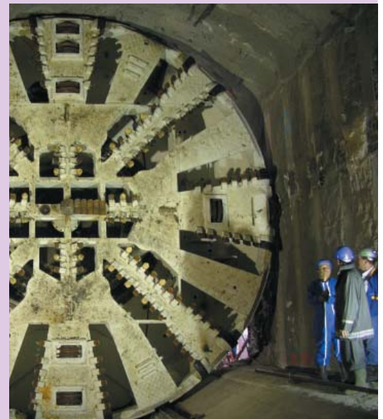
b. Tête de tunnelier dans la galerie d'attaque du puits Masséna du tunnel réservoir Ivry-Masséna (TIMA)
